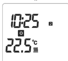
Beispiel Betriebsart „Komfort“
